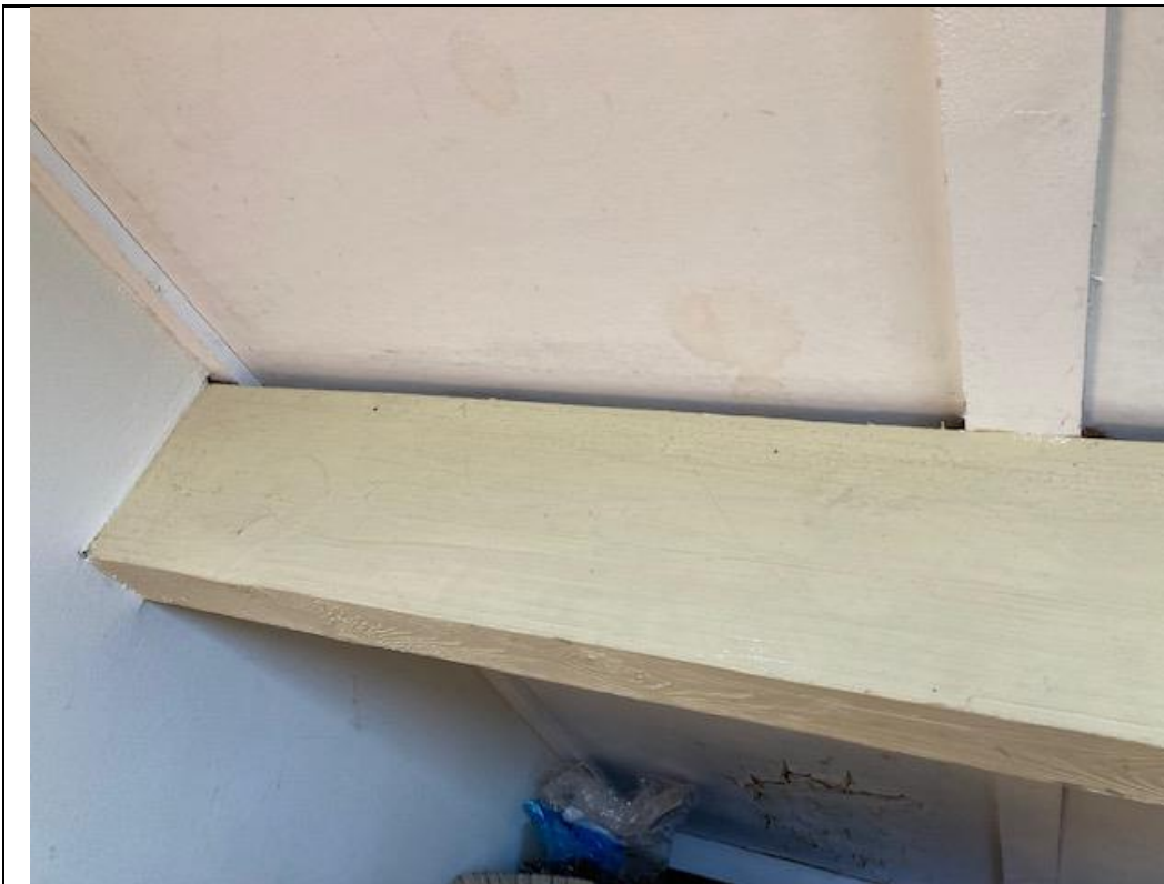
Foto ; Huidig dak aan de binnenzijde van de Stramit platen met rachel (ca 1,8 cm dik). Gording meet 15 cm diep en 6 cm dik.
