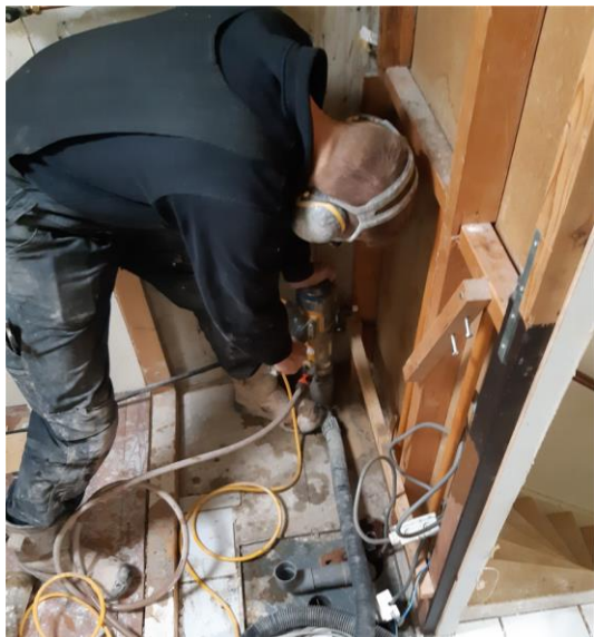
Boren sparingen in vloeren t.b.v. bronleiding
