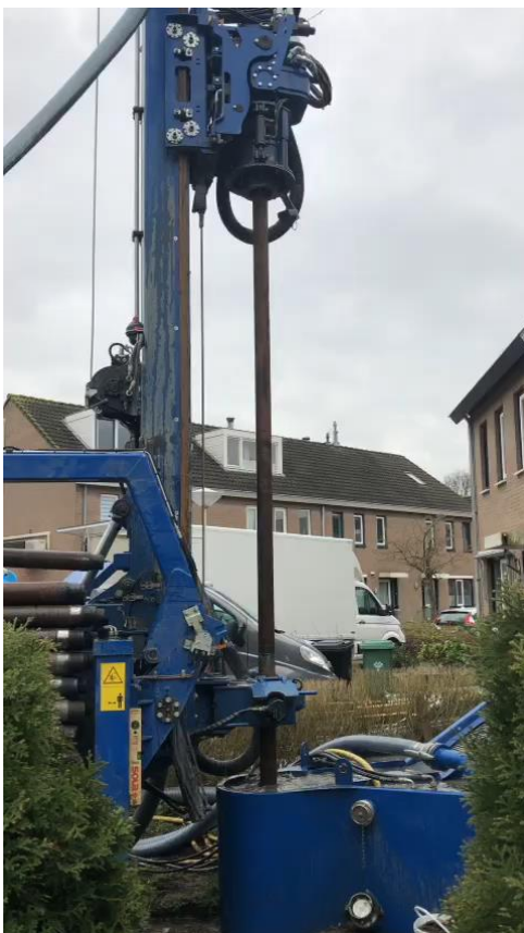
Boormachine in actie
