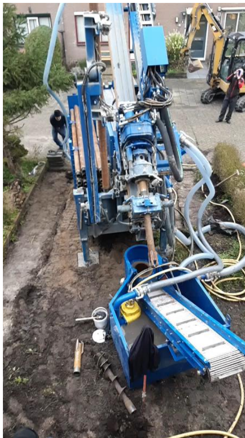
Opzetten boormachine
