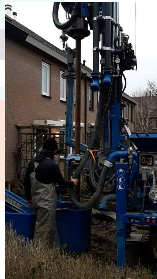
Boormachine in actie
