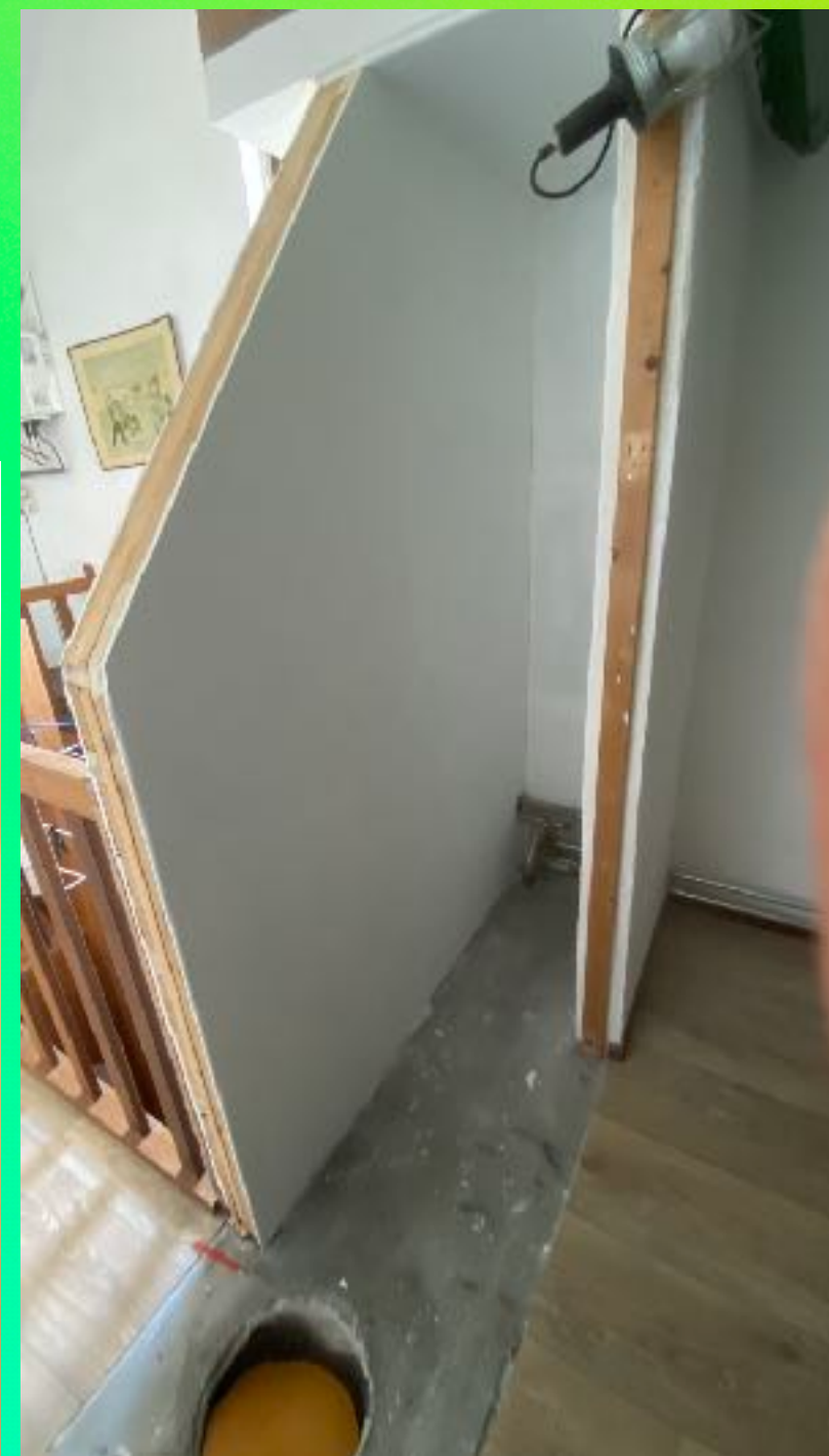
Herstel van het sloopwerk
